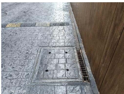
บ่อ Man Hole ที่ใช้เป็นระบบบ่อหมุนน้ำ
