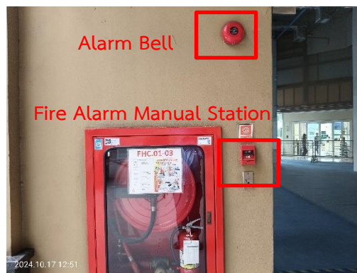
Alarm Bell และ(Fire Alarm Manual Station)
